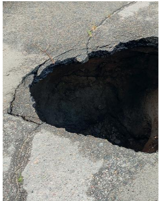
Straßenschäden durch Unterspülung
