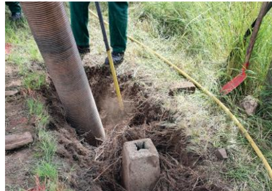
Die teure Alternative ist der Saugbagger oder die Handschachtung
